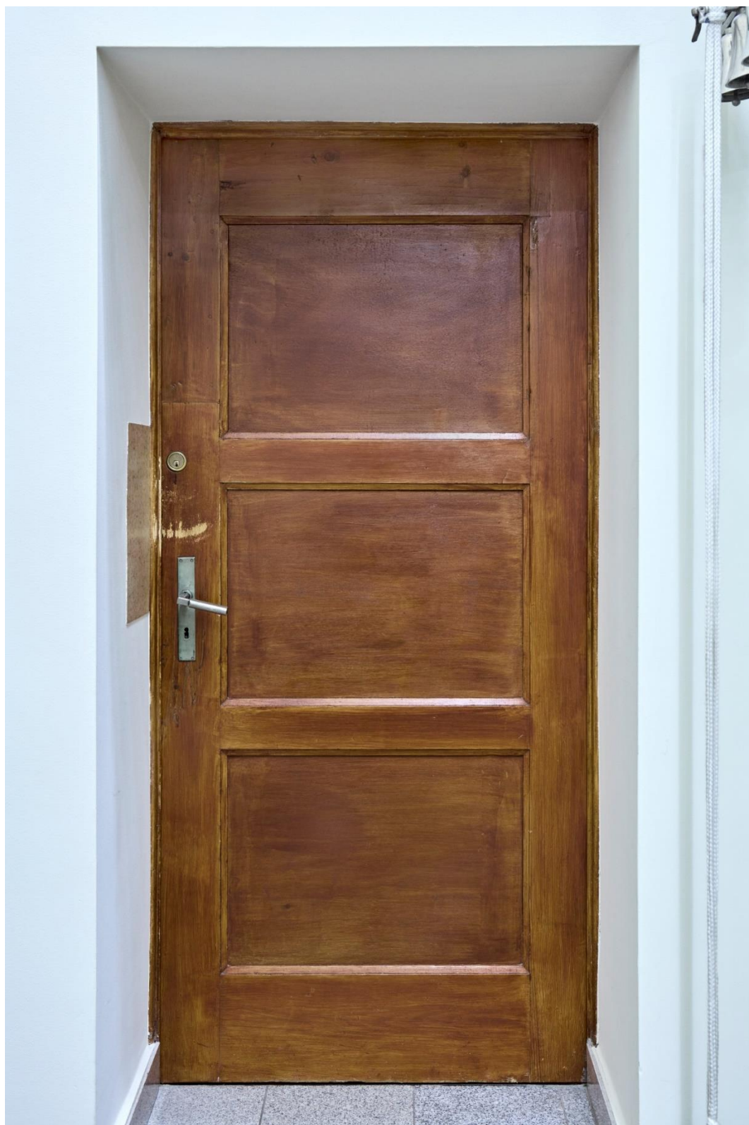
Fot. 19. Drzwi do zakrystii oczyszczono z nawarstwień stratygraficznych. Powierzchnię podobnie jak na drzwiach wejściowych, zabezpieczono lakierobejcą. W sąsiedztwie zamka widoczne naprawy – najprawdopodobniej jest to ślad zniszczenia (włamania lub jego próby).
