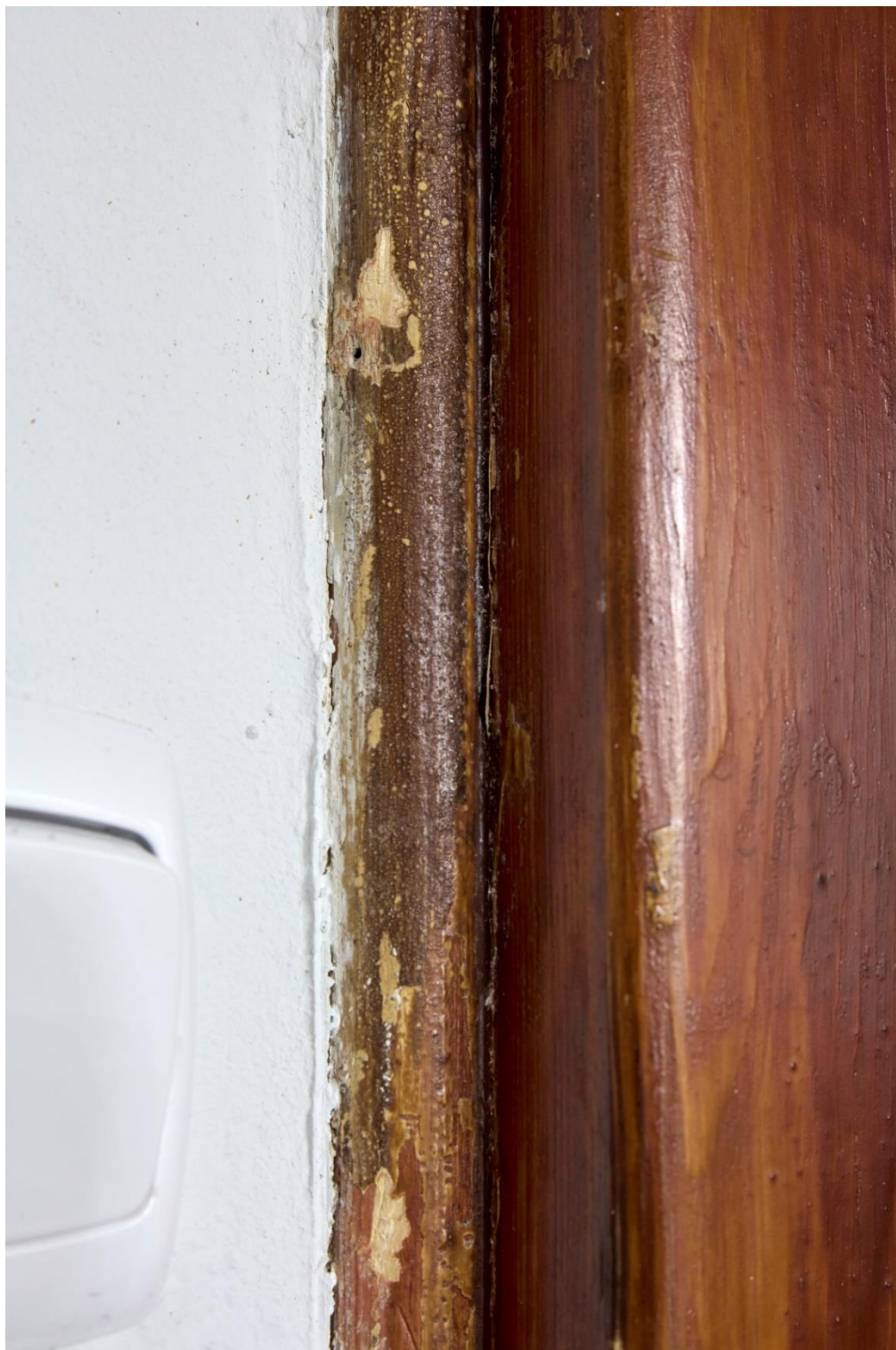
Fot. 10. Na bocznej listwie (półwałku) maskującym krawędź ościeżnicy wahadłowych zachowały się nieusunięte fragmenty mazerunku. Lakierobejca, którą położono na powierzchnię drzwi przyciemniła zachowane relikty opracowania.
