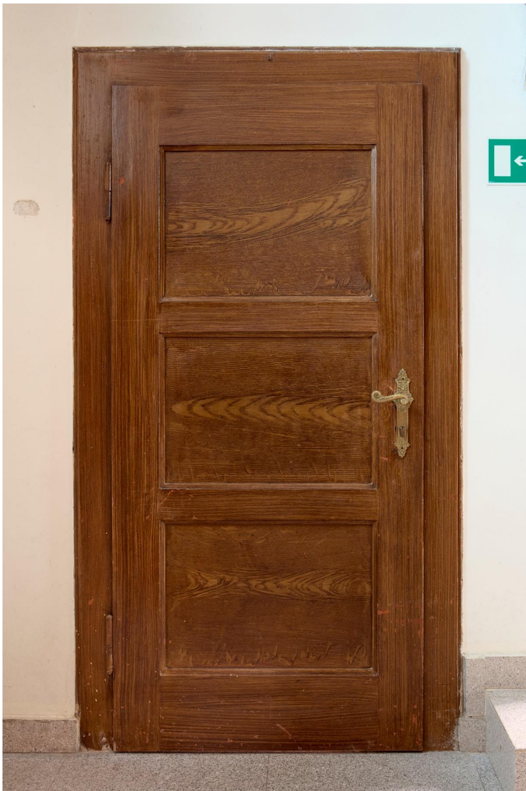
Fot. 13. Drzwi usytuowane po lewej stronie prezbiterium prowadzące do pomieszczeń gospodarczych oraz bocznego wyjścia z kościoła. Pod warstwą mazerunku w ubytkach widoczna jest powłoka malarska w kolorze jasnobrązowym. Najprawdopodobniej mazerunek jest opracowaniem drugim chronologicznie, które wykonano na wszystkich drzwiach w kościele. Współcześnie zachowany jest tylko na dwóch sztukach drzwi w części gospodarczej kościoła. Dekoracyjna klamka jest wtórna. Pierwotne zachowały się w pozostałych drzwiach.
