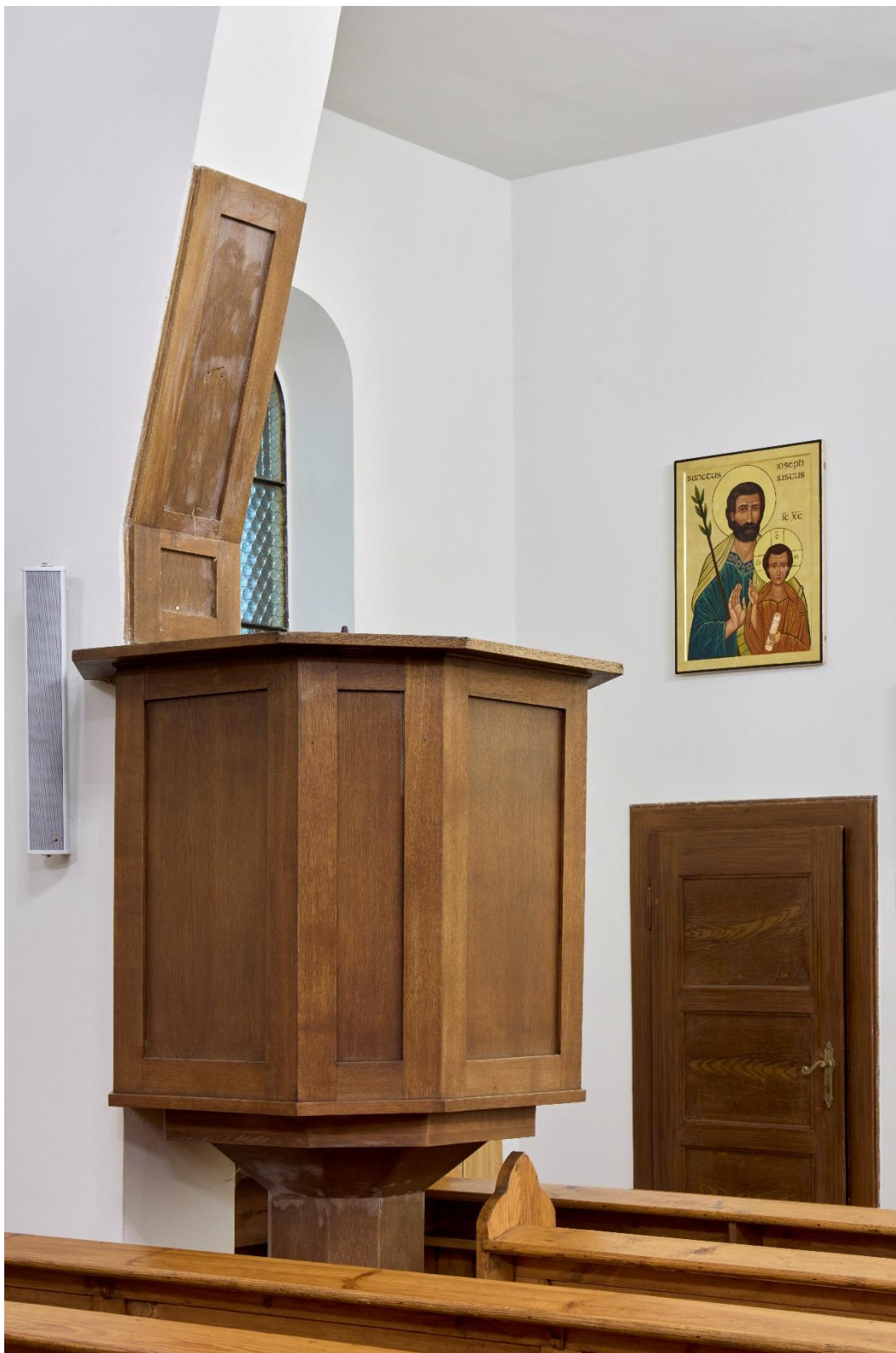
Fot. 29. Ambona, widok z boku, od strony wejścia do kościoła (od północnego zachodu). Pierwotnie ambona zwieńczona była baldachimem, który umieszczony był powyżej zachowanego zaplecka. Na jego powierzchni widoczne jest zabielenie – efekt kondensacji pary wodnej. Zdjęcie wykonano w lutym, podczas odwilży, kiedy temperatura na zewnątrz była wyższa niż wewnątrz kościoła. Na stopie ambony politura jest niemal całkowicie wytarta.
