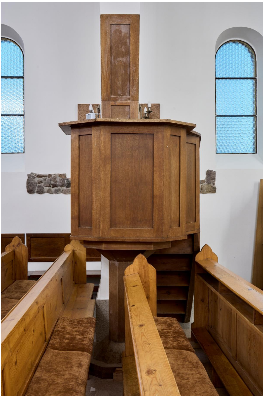
Fot. 30. Ambona, widok na wprost. Kosz, zaplecek, stopa oraz balustrada wejścia wykonane zostały z drewna dębowego, stopnie wejścia – z drewna iglastego (sosnowego). Powierzchnię pokrywa zmato-wiała, wytarta politura. Wprawdzie w latach 30. XX w. powszechnie stosowano już lakier nitrocelulo-zowy, jednak w tym przypadku zastosowano tradycyjną metodę zabezpieczenia powierzchni. Powłoka rozpuszcza się pod wpływem etanolu.
