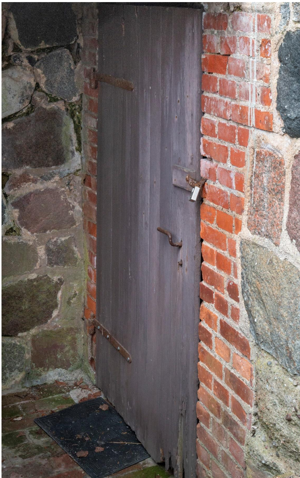
Fot. 22. Drzwi do piwnicy mają konstrukcję deskową, zamek puszkowy oraz zawiasy pasowe. Drewno jest silnie zdegradowane, stolarka powinna zostać wymieniona na nową o analogicznej konstrukcji. Zalecane byłoby przeniesie zamka do nowej stolarki, nawet jeśli zostanie wykonane dostawowe, współczesne zamknięcie.
