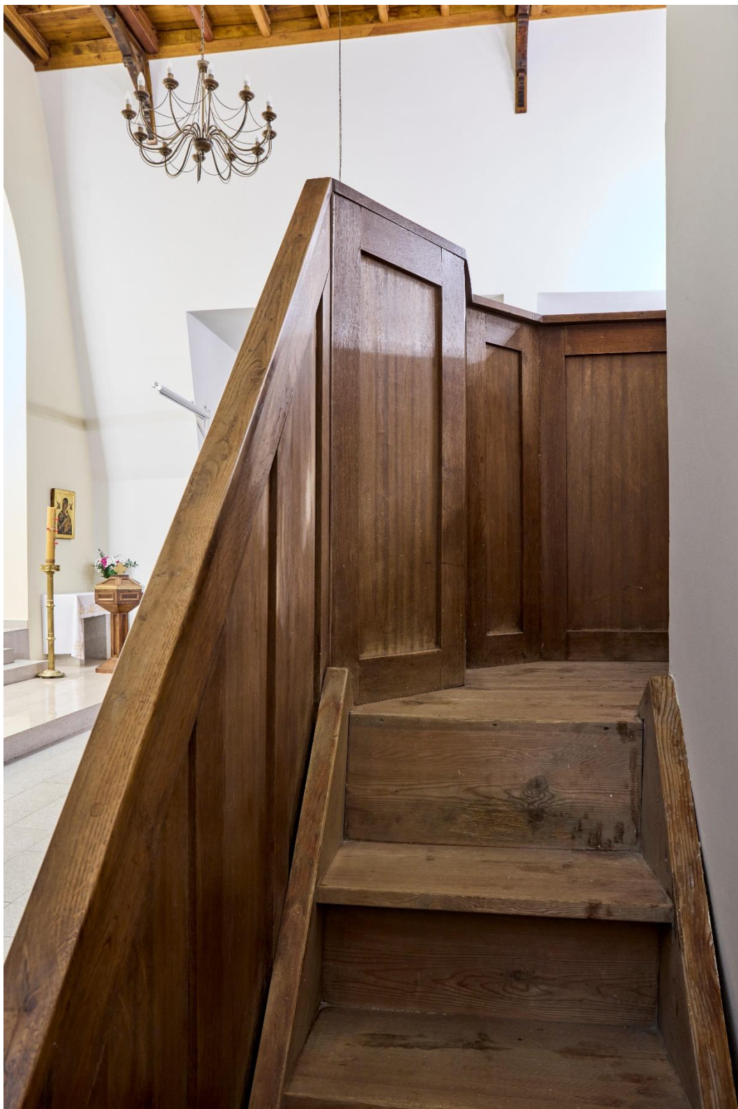
Fot. 32. Wejście na ambonę. Schody w przeciwieństwie do dębowej konstrukcji kosza wykonane zostały z drewna sosnowego. Powierzchnia stopni narażona jest na zawilgocenie (podczas użytkowania oraz mycia). Wilgoć mogła przyczynić się do rozwoju grzybów, a następnie szkodników drewna. Na powierzchni obserwować można otworki typowe dla żerowania kołatka domowego.
