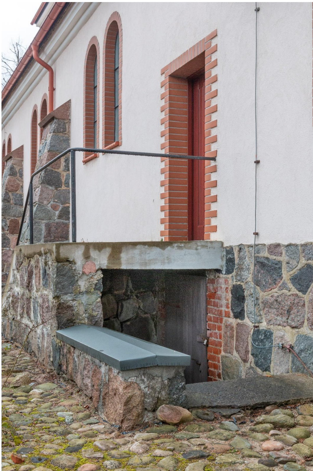
Fot. 21. Drzwi w bocznych wejściach do kościoła wymieniono. Zachowane są jedynie deskowe-listwowe drzwi prowadzące do piwnicy.
