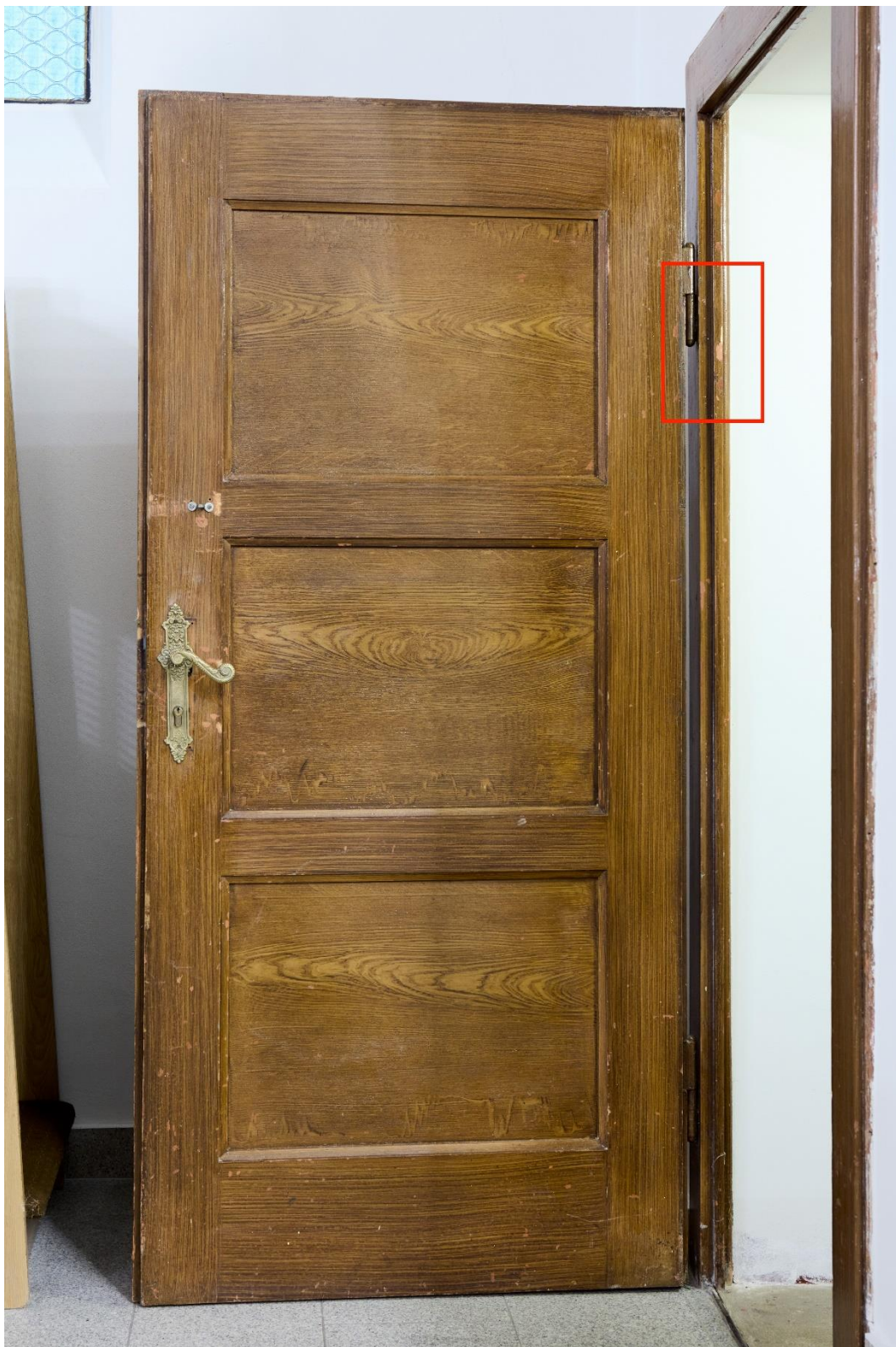
Fot. 14. Drzwi prowadzące z kościoła do pomieszczeń gospodarczych, widok od strony zewnętrznej, na której wyraźnie widoczne są uszkodzenia oraz fragmenty zachowanej pod spodem warstwy w kolorze jasnobrązowym. Ramką zaznaczono miejsce wykonania odkrywki i pobrania próbki.
