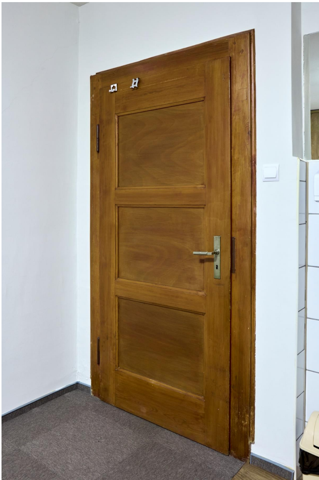
Fot. 20. Wejście do zakrystii z zewnątrz. Także tu zachowana, oryginalna stolarka została oczyszczona z nawarstwień stratygraficznych, a powierzchnia drewna zabezpieczona lakierobejcą.
