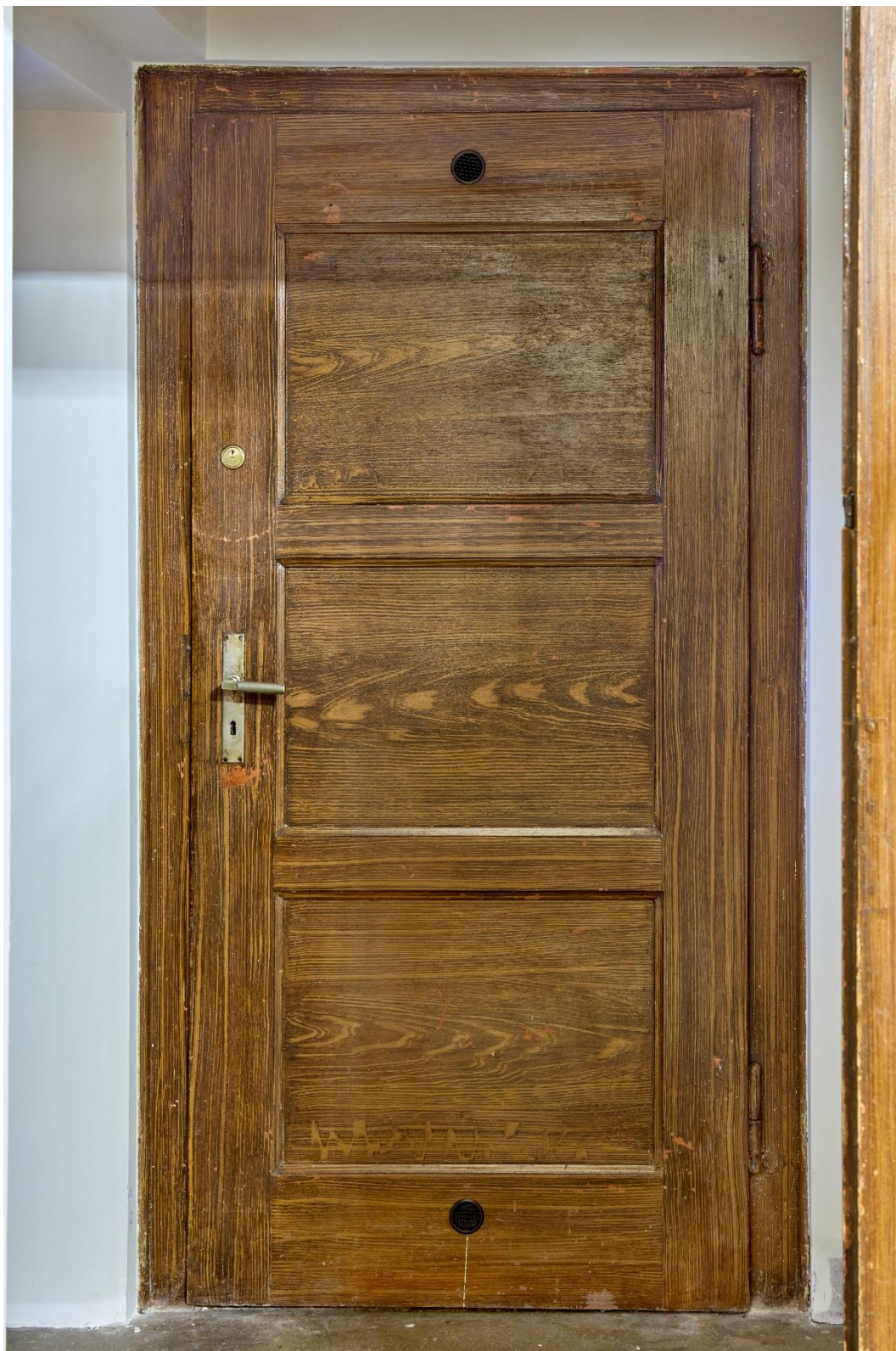
Fot. 18. Skrzydło drzwi do pomieszczenia gospodarczego. Klamka i szyld są najprawdopodobniej oryginalne. Poniżej szyldu ubytek, w którym widoczna jest jasnobrązowa warstwa malarska. W górnej i dolnej listwie ramy wtórnie zamontowano wywietrznik.
