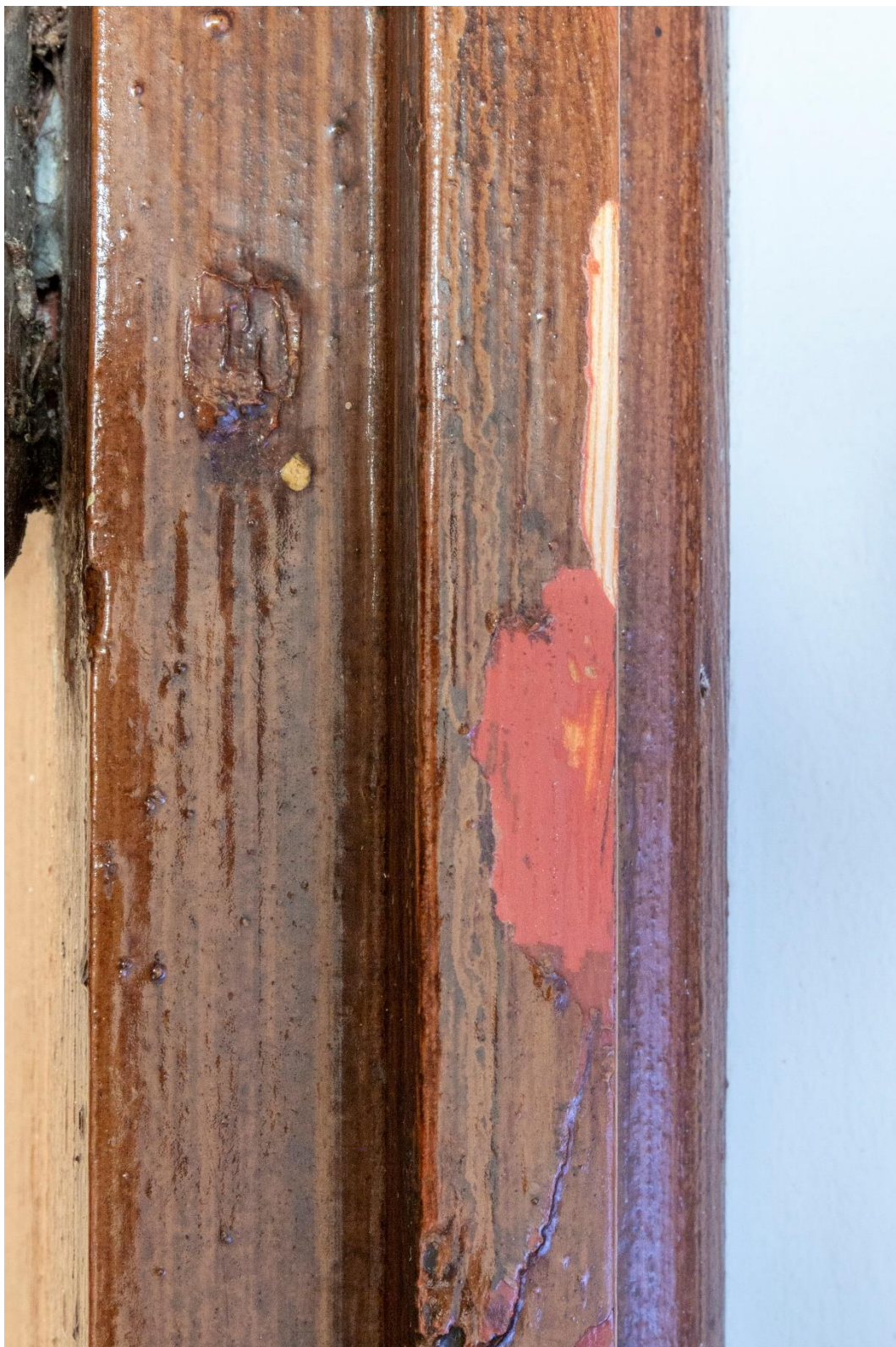
Fot. 15. Odkrywka na ościeżnicy drzwi prowadzących do pomieszczeń gospodarczych i bocznego wyjścia z kościoła (po lewej stronie prezbiterium). Pod mazerunkiem pierwsza chronologicznie, jasnobrązowa warstwa malarska.
